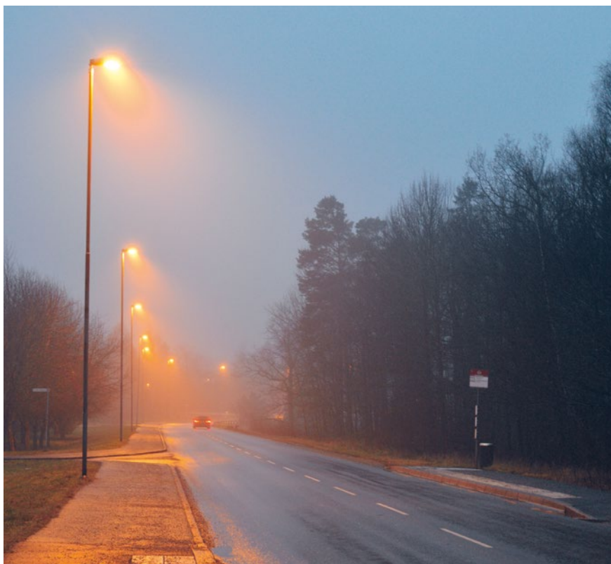
Kollektivt resande ska underlättas. Då har vägbelysning en betydelsefull roll. Foto: Henrik Gidlund
